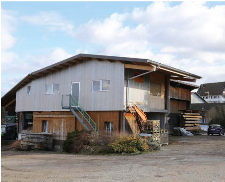
Die Heizzentrale und das Schloss
